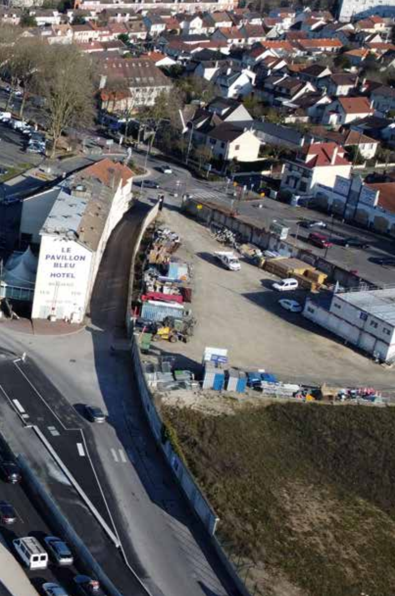
d'achèvement des travaux sur le carrefour giratoire "Pavillon bleu"
