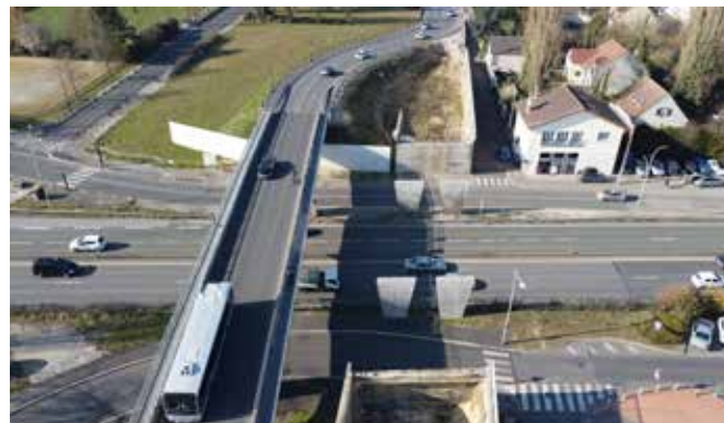
Destruction des piles et culées restantes de l'ancien pont Marcel Cachin
